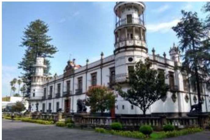
Edificio Principal, hoy Rectoría. Chapingo. Texcoco, México
